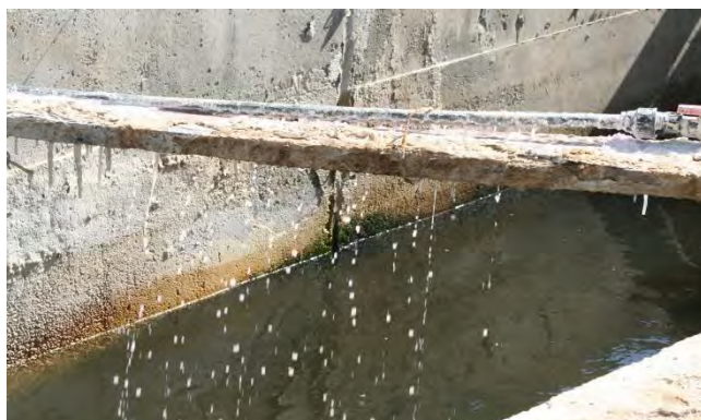
شکل ۲: نمایی از نحوه افزوده شدن بلیچ به پساب در تصفیه‌خانه فاضلاب جنوب اصفهان.
